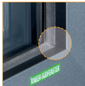
Außenansicht Gerade Flügelwange (Bezeichnung S vermerkt)
